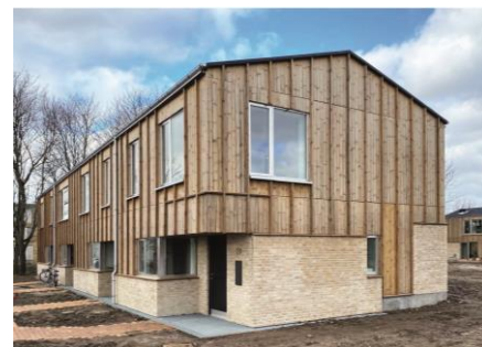
Billede der viser rækkehus i træ og gule tegl opført i etape 1. Foto Vandkunsten.
