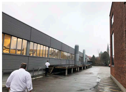
Kig mod Jesuskirken på den anden side af jernbanen - eksisterende forhold. Foto af Juul Frost Arkitekter.
