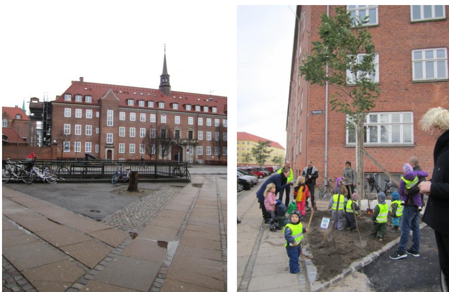
Fig. 3: Arresøgade: Dødt træ i asfalt, nyt træ i større plantehul med stauder og løg
