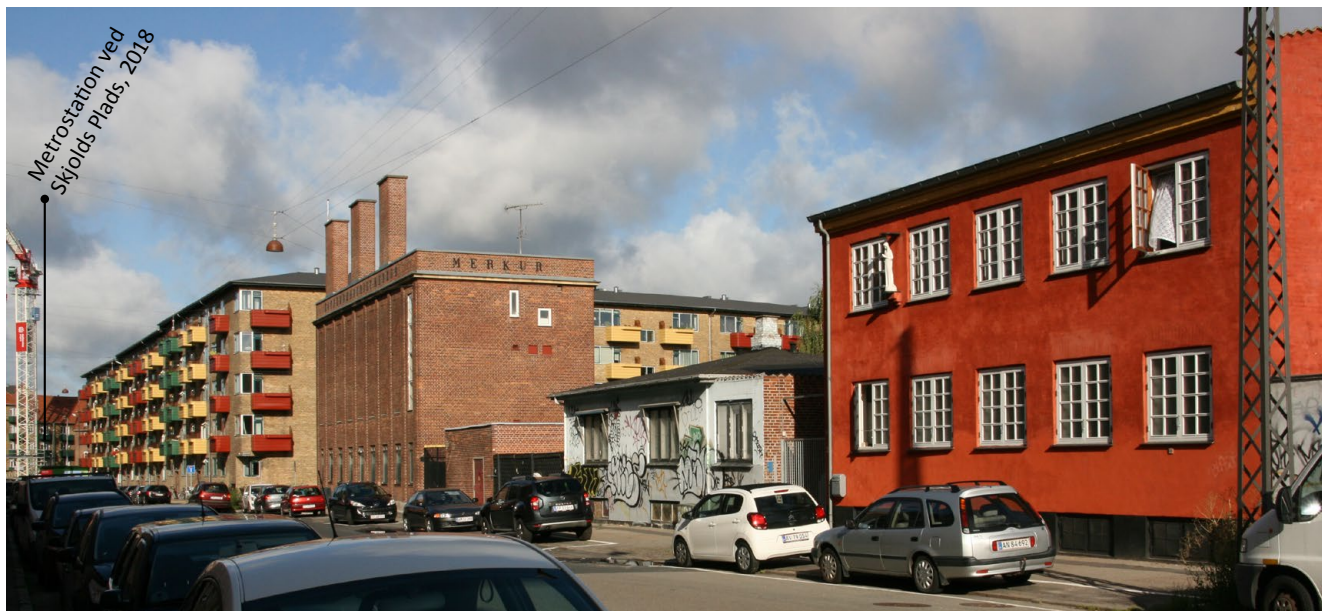
Sigurdsgade falder med ca. 3 meter fra øst mod den kommende metrostation ved Skjolds Plads i vest. (Foto: Københavns Kommune)
