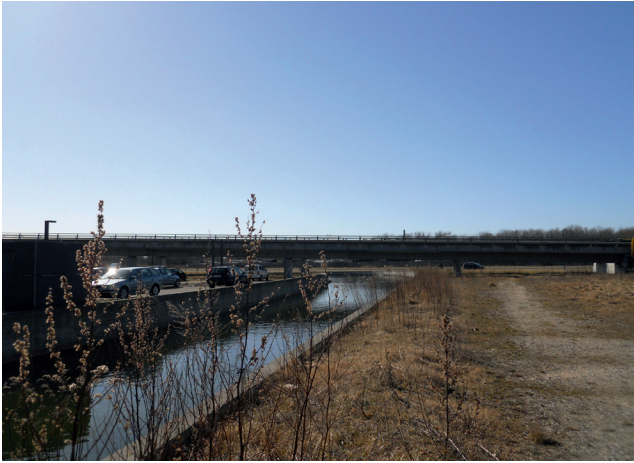
Byggegrunden støder mod syd op til den landskabelige kanal og mod vest til Metro.
