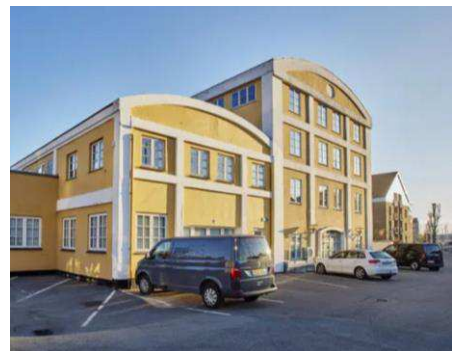
Eksisterende bygninger på Wilders Plads 8. Bygningerne er udpeget som bevaringsværdige og bevares. Foto: Lundgaard & Tranberg Arkitekter.
