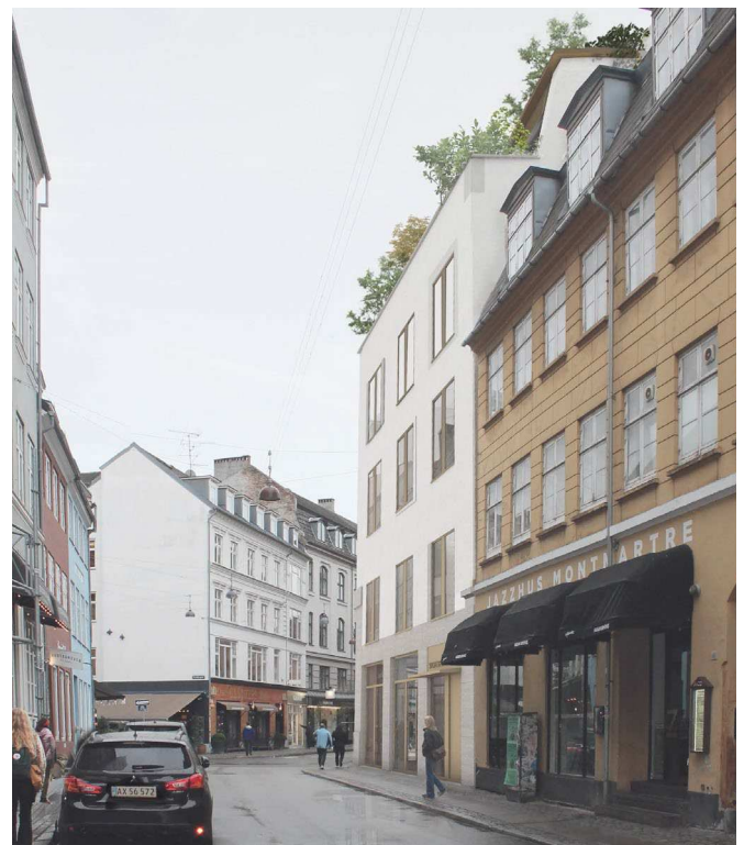
Den nye bygning viderefører disse spring, som er karakteristisk for området. Foto og perspektiv Praksis Arkitekter
