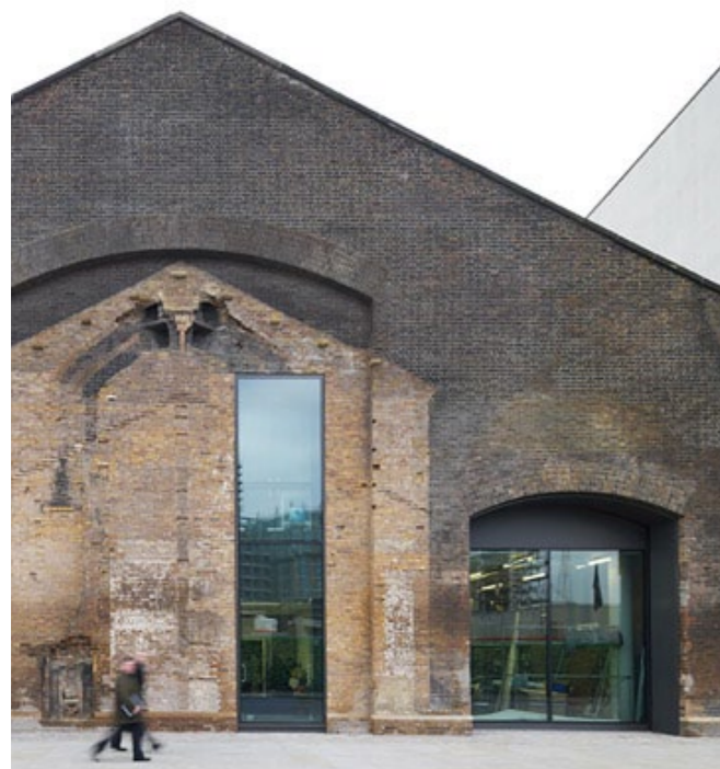
FACADESPOR / NYT VINDUESHUL CENTRAL ST. MARTINS, LONDON
