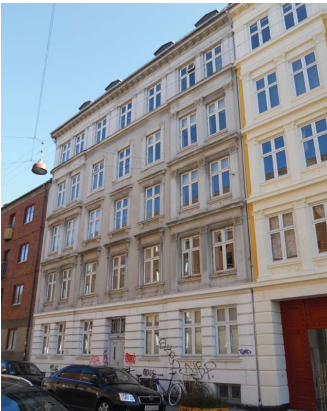
Ejendommen set fra gadeside
