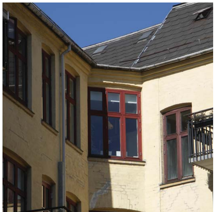
Nyt tag, tagrender og efterisolering
