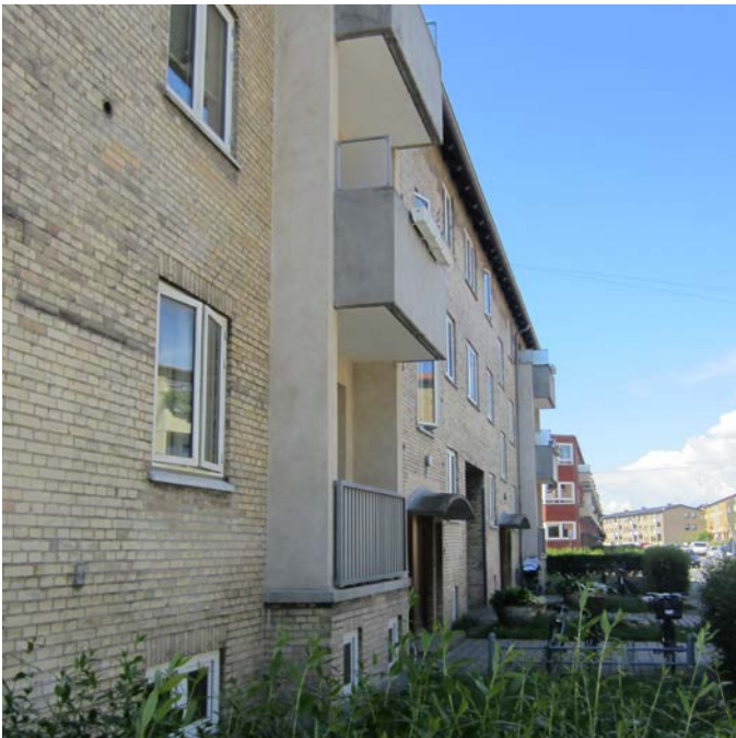
Händelsvej, efterisolering af kældergange
