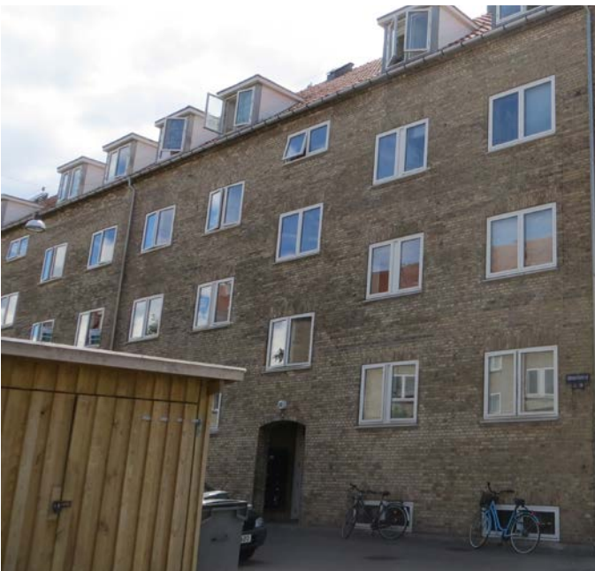
Facader af Stradellasvej og i spejlingen Tartinisvej
