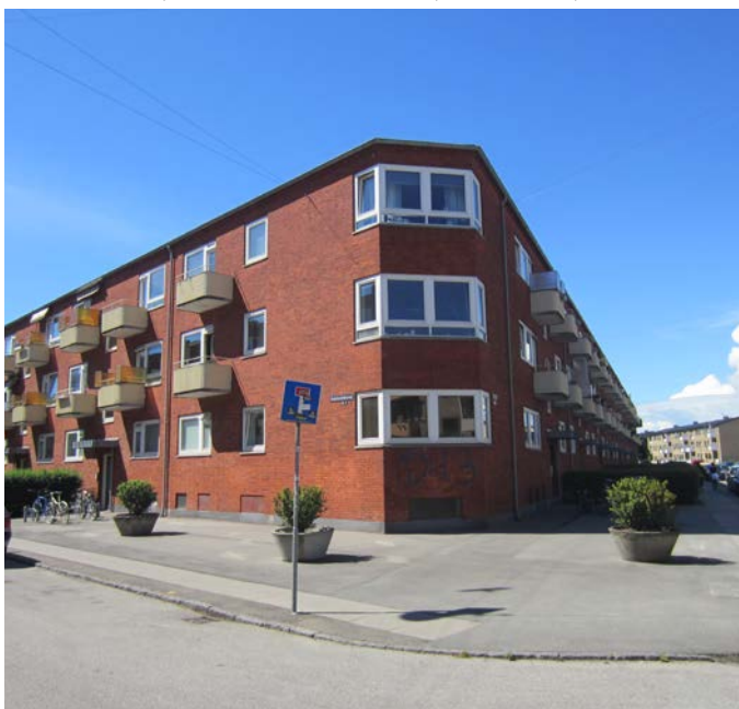
Facade mod hjørnet af Rubinsteinsvej/Händelsvej
