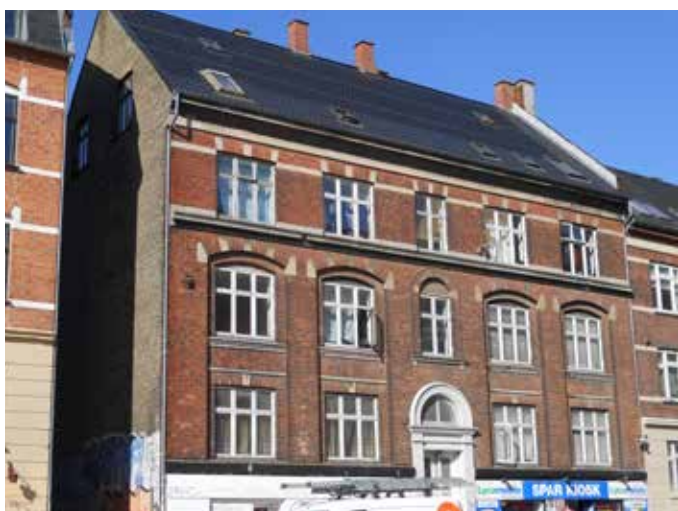
Gavl efterisoleres udvendigt og facader indvendigt
