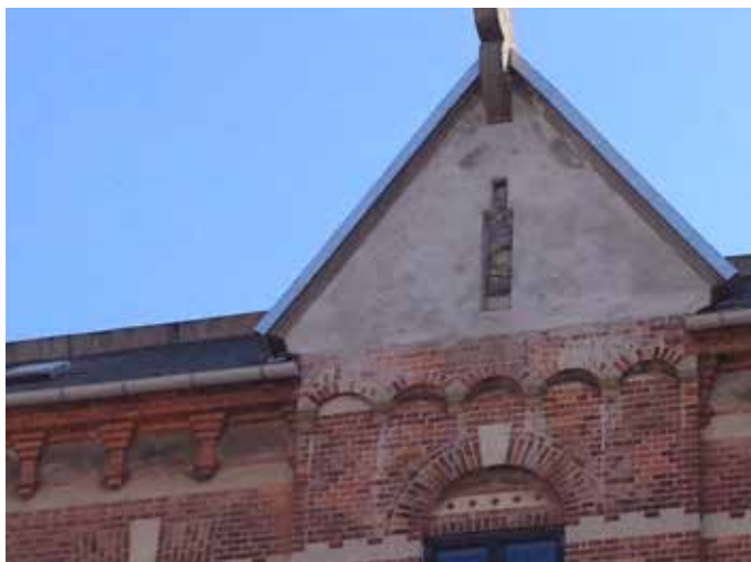
Tidligere uheldige forsøg på facaderenovering udbedres
