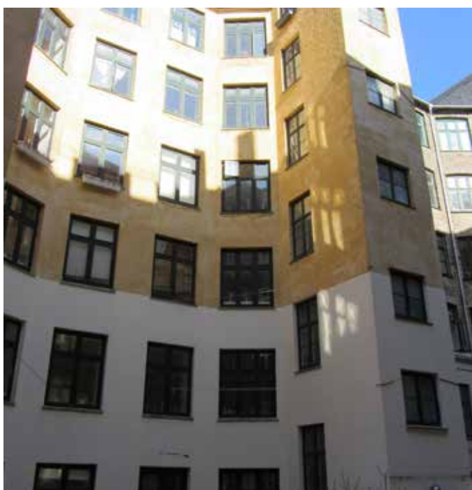
Facader istandsættes og bitrapper inddrages til wc/bad
