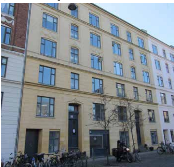
Ejendommen set fra gadesiden
