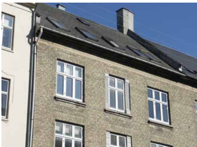
Facader og døre istandættes, vinduer og tag udskiftes
