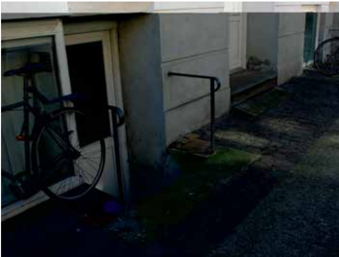
Ejendommen skybrudssikres og der laves omfangsdræn
