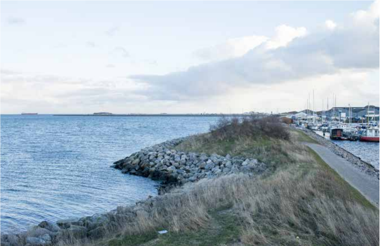
Figur 8.9 Eksisterende forhold ved Nordhavns nordspids. Fotoet er taget mod sydøst.
