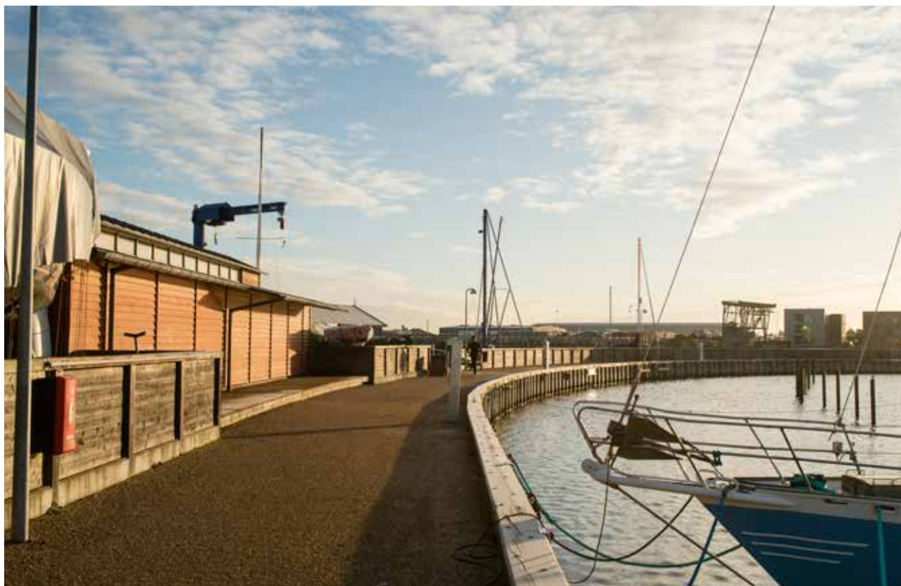
Figur 9.14 Eksisterende forhold ved Svane knoppen og Kalkbrænderiløbet. Fotoet er taget fra Svane knoppen mod øst.
