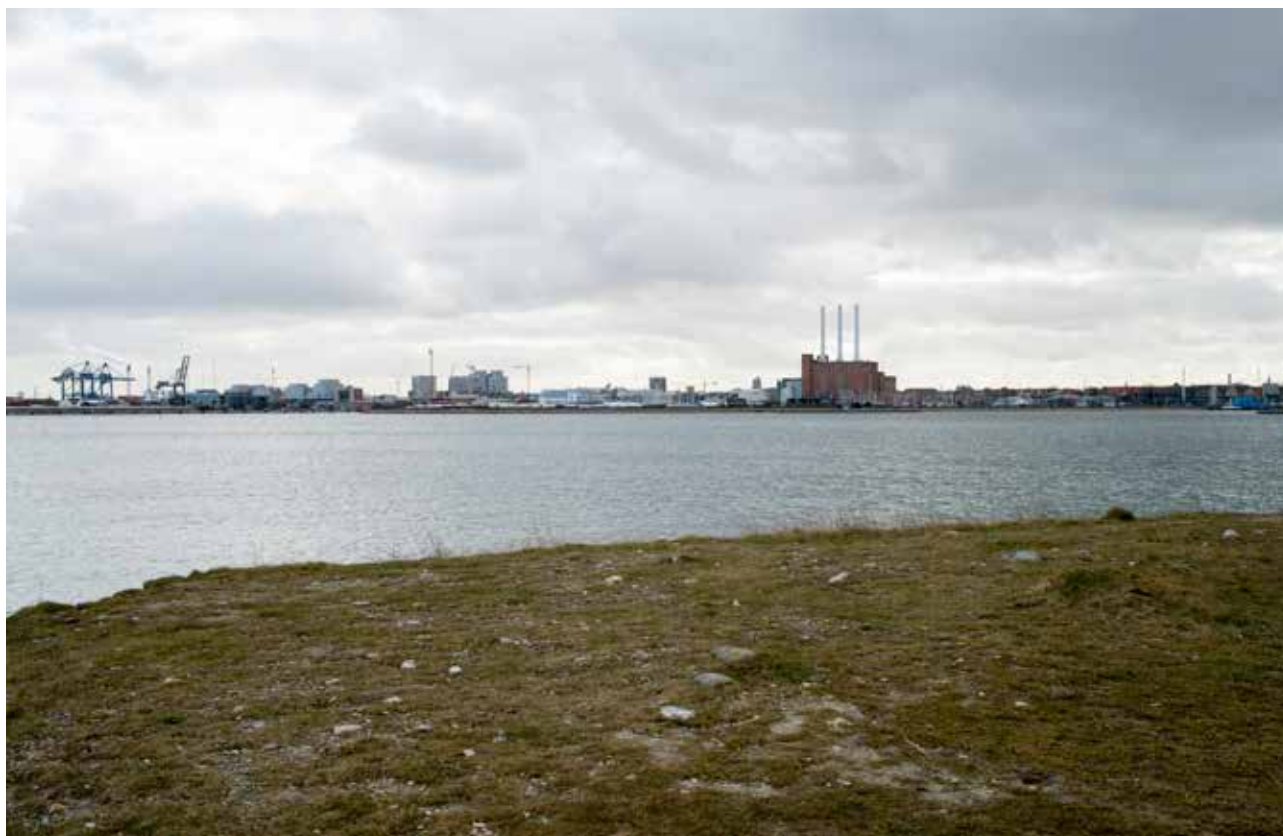
Figur 6.9 Eksisterende forhold ved Svaneknoppen. Fotoet er taget mod syd.
