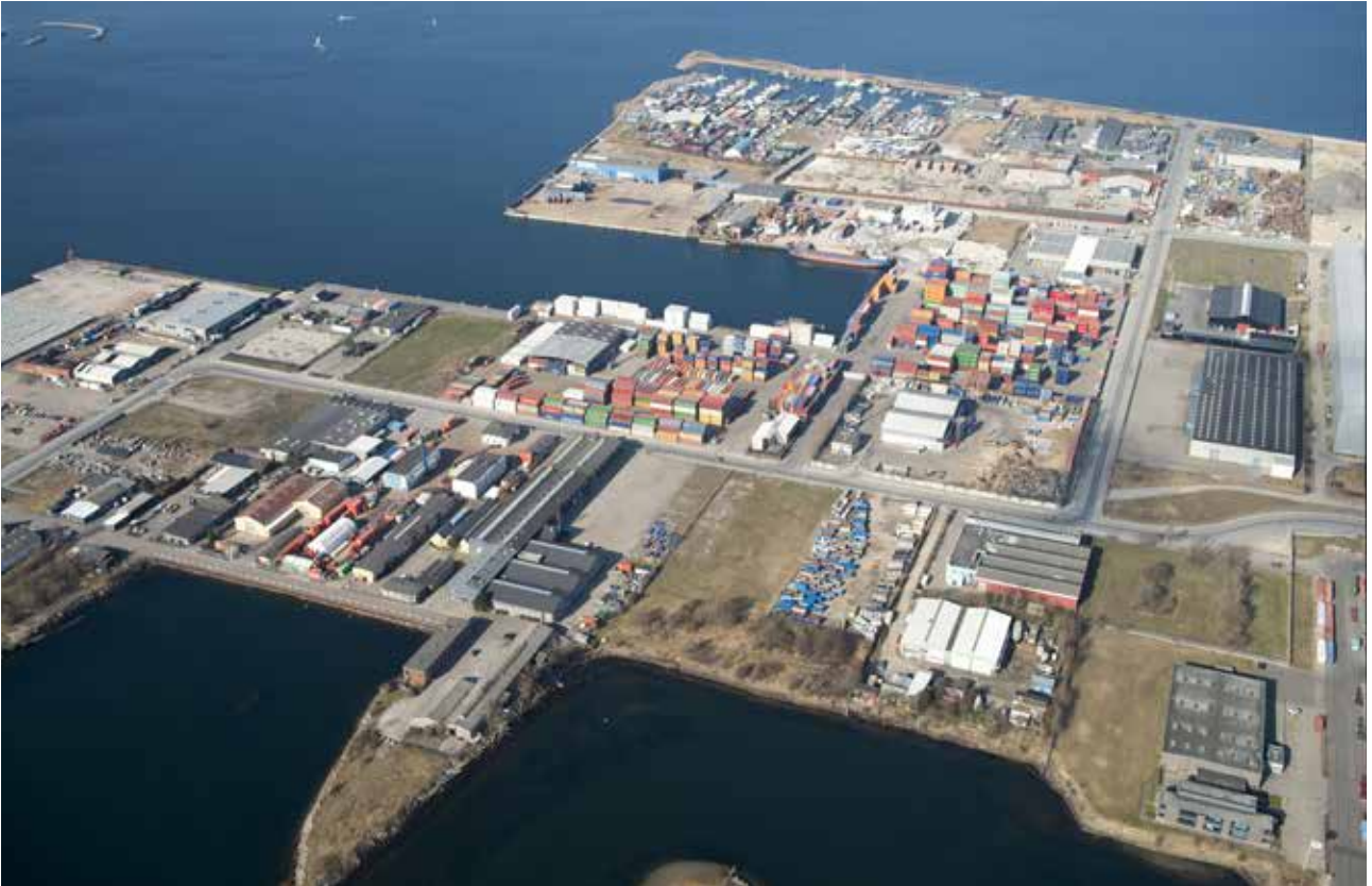
Figur 4.8 Eksisterende forhold omkring Baltikavej og Kattegatvej på Nordhavn. Luftfotoet er taget mod nord.
