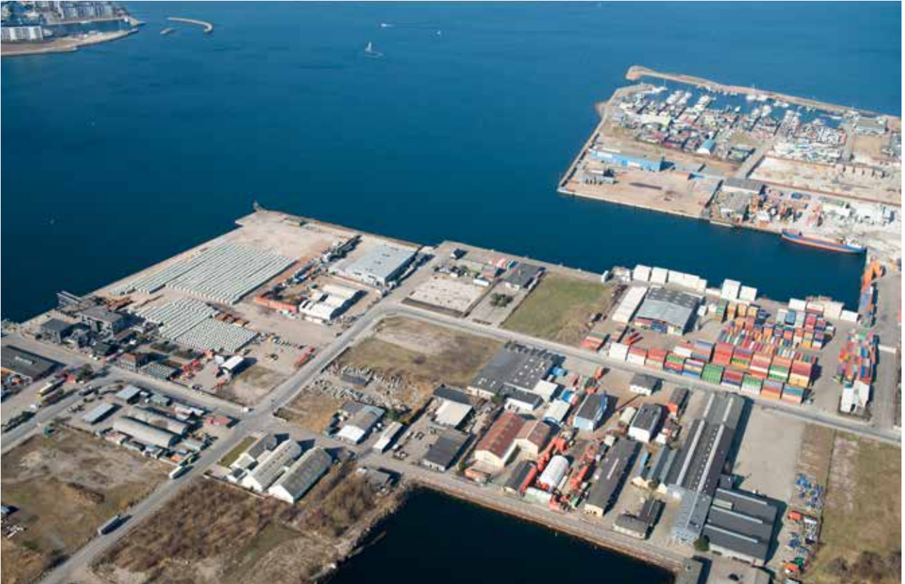
Figur 4.12 Eksisterende forhold omkring Baltikavej og Færgehavnsvej på Nordhavn. Luftfotoet er taget mod nord.
