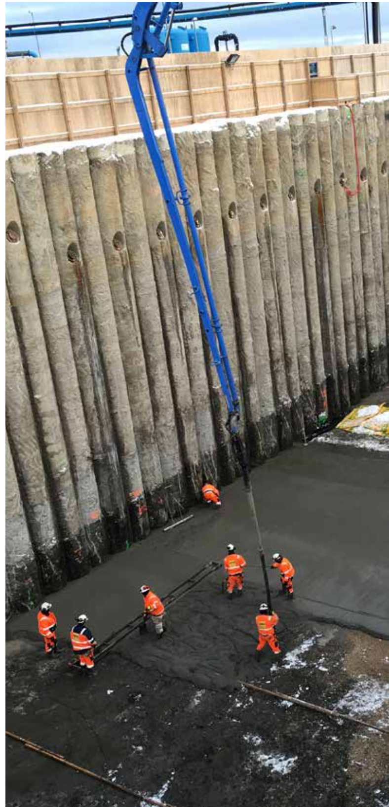
Konstruktionsarbejde i en byggegrube, som er afgrænset af sekantpæle.
