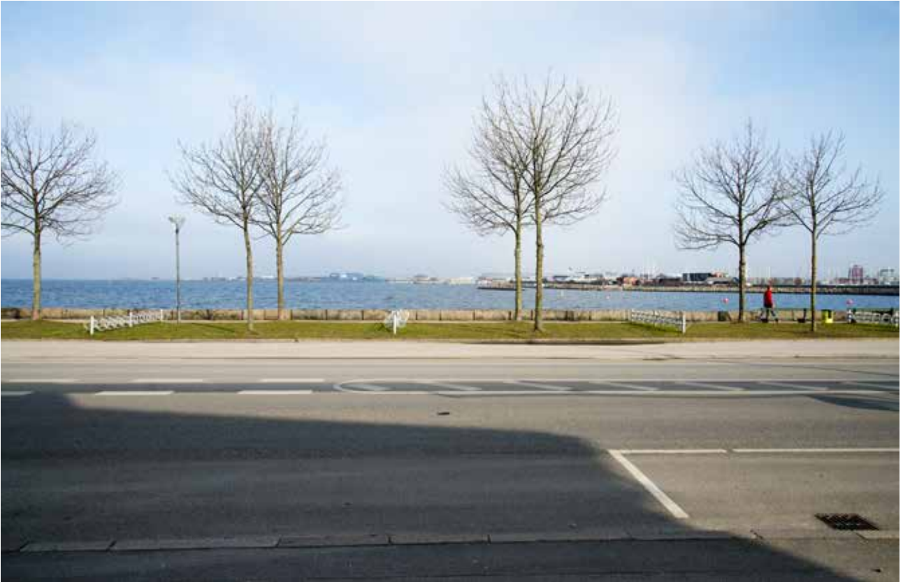
Figur 8.13 Eksisterende forhold i Svanemøllebugten. Fotoet er taget mod syd.
