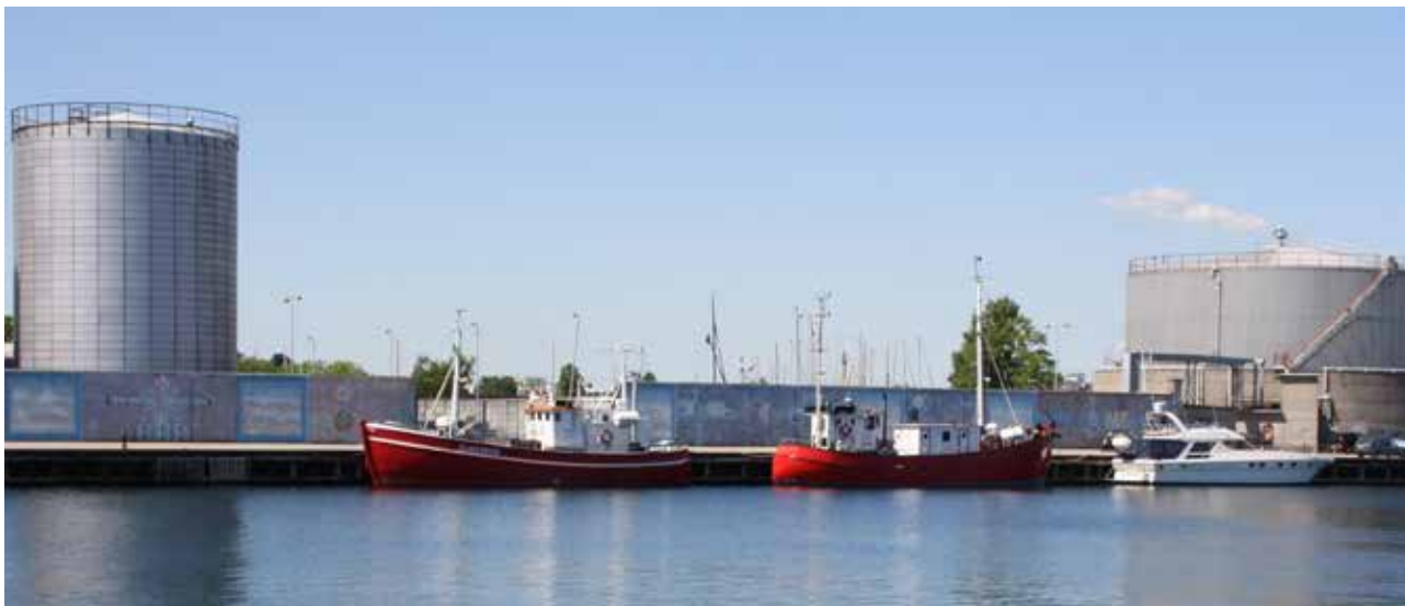
Siloer ved Lautrupskaj foran Svanemølleværket.
