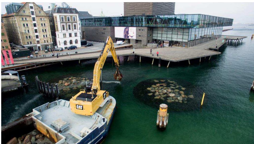
Etablering af stenrev ved Skuespilhuset 2017.
