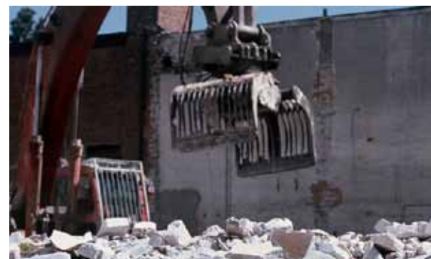
NEDRIVNING AF BYGNING
