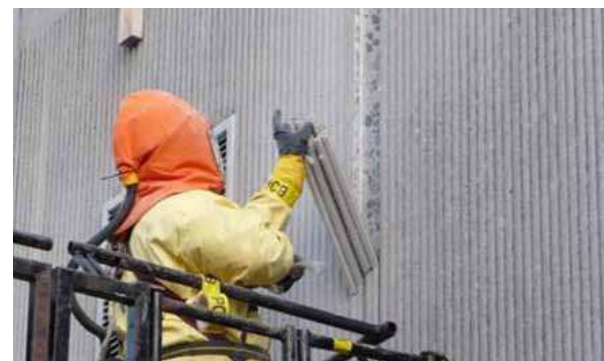
RENSNING AF BYGNING INDEN NEDRIVNING
