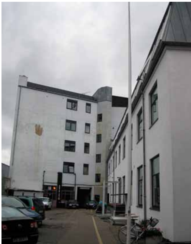
Heimdalsgade 35-37, set fra gårdsiden
