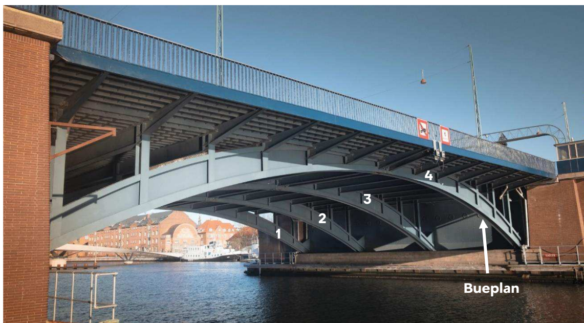
Broklappernes fire bærende bueplaner
