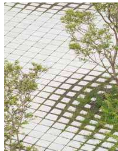
Permeable overflader som del af belægning
