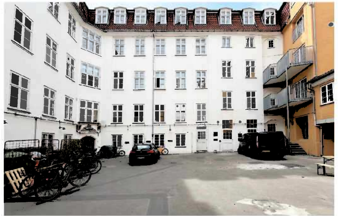
Billede fra stedet – Eksisterende gårdtrum og bygninger. Blik mod vest. De hvide bygninger er nr. 32. Gul bygning er nr. 32A.
