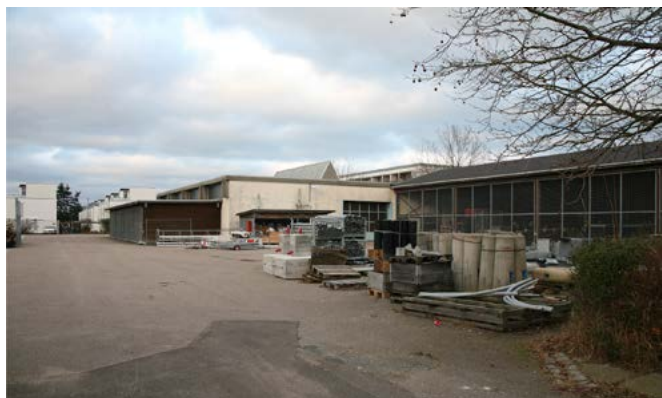
Eksisterende værkstedsbygninger på lokalplanområdet
