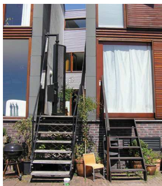
Boliger i stueetagen med trapper. Reference: Amsterdam.
