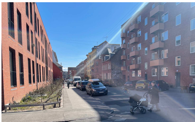
Illustration 1: På Theklavej varierer bygningshøjderne fra 1-5 etager, hvilket skaber et varieret gadeforløb. Frem til nu er nyere bebyggelse langs Theklavej bygget i 3 etager eller 4 etager med et markant indryk på øverste etage, hvilket passer fint til områdets egenart.
