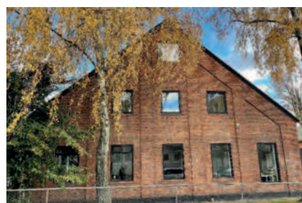
Bedre Byggeskik, Peter Ibsens Allé 24.
