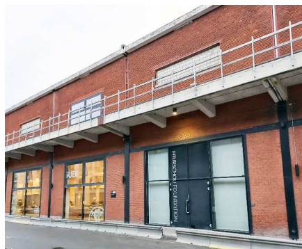
Bevaringsværdig bygning – Pakhus 53.
