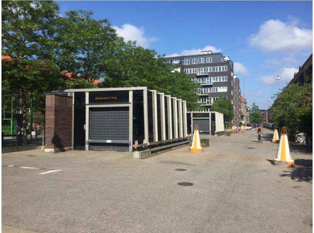
Eksisterende automatisk parkeringsanlæg ved Gunløgsgade på Islands Brygge.
