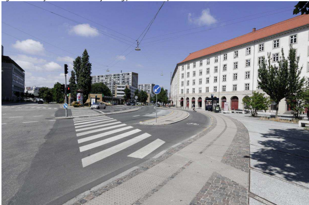
Figur 22. Foto af det eksisterende vejareal og plads ved Borups Plads.
