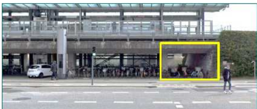
Figur 8-26 Vestamager St. set fra Ørestads Boulevard. Indgang til tunnel under bane er markeret med gul. Foto: Google.
