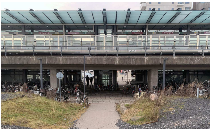
Undergangen under Amager Vest Metrostation set fra lokalplanområdet og ud mod Ørestads Boulevard.
