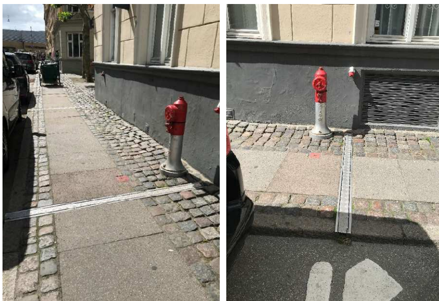
Figur 1 Eksempel på kabelskinne Colbjørnsensgade 28
