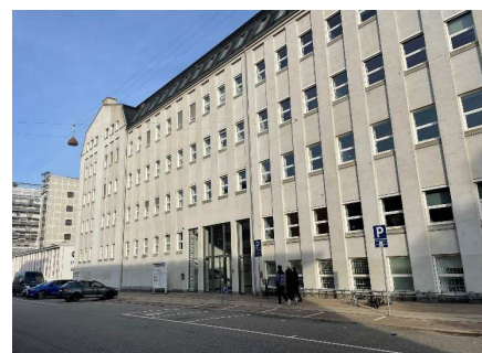
4. Fabriksbygninger opført mellem 1921-1942, der udpeges som bevaringsværdig.
