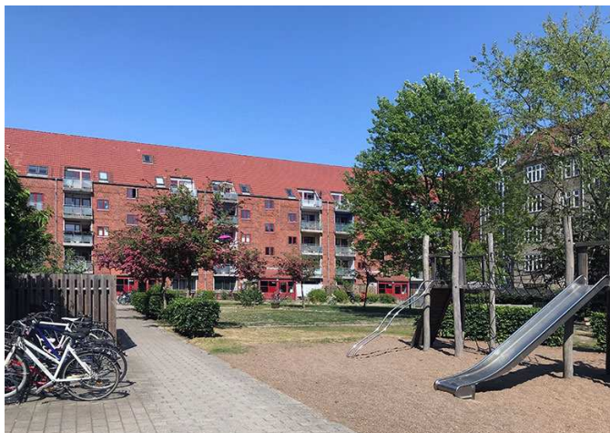
Gårdrummet set fra det sydvestlige hjørne, hvor der er fælles legeplads. Opgange til de almennyttige boliger er placeret langs gårdrummets kant.
