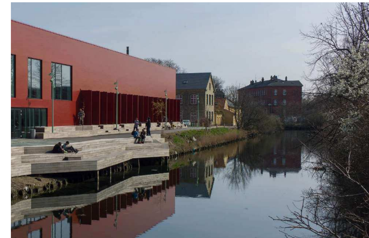
Eksisterende trappeophold ved Hal C
