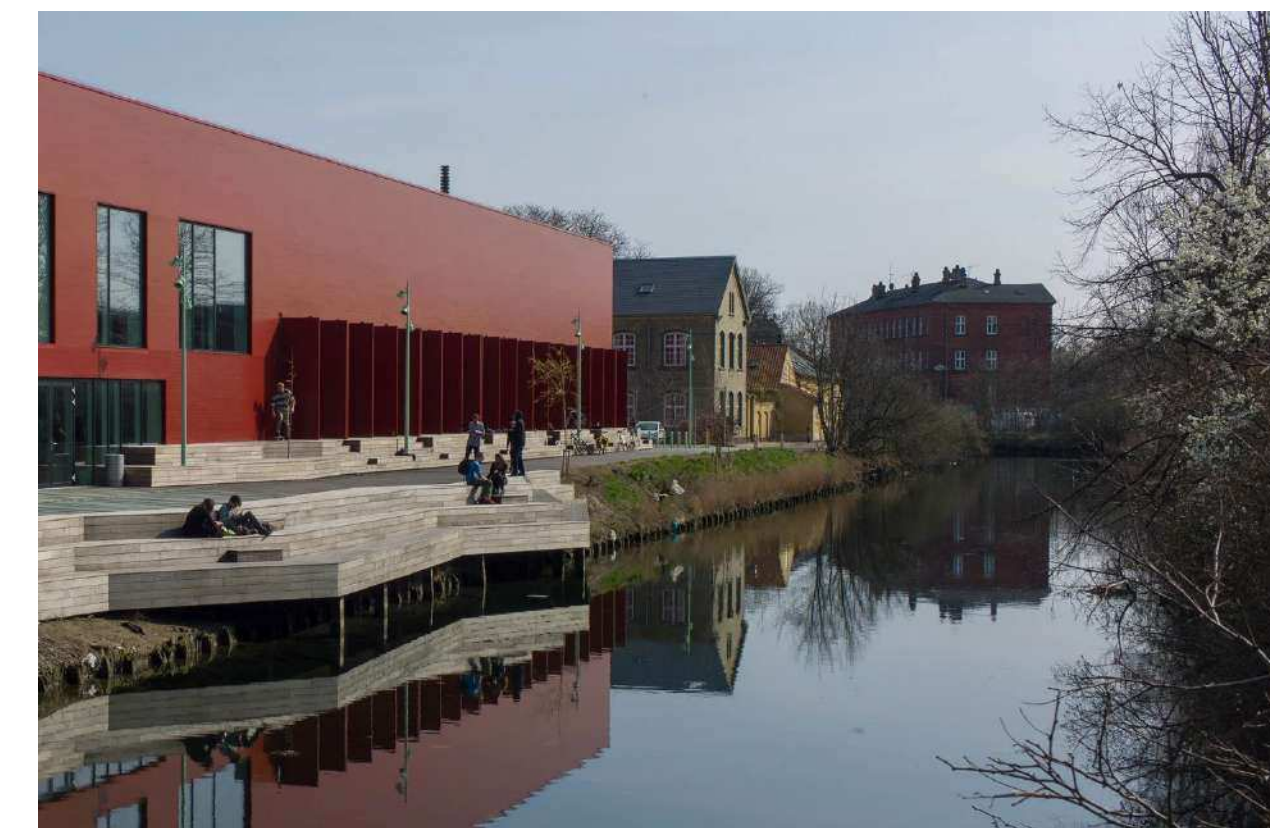
Eksisterende trappeophold ved Hal C
