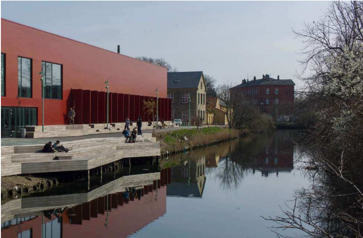
Eksisterende trappeophold ved Hal C
