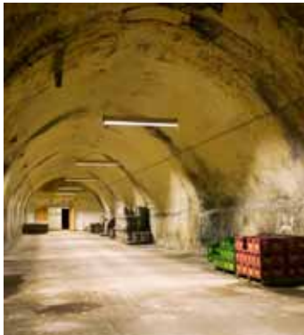
Kælderen under Rød Lagerbygning.
