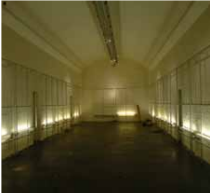
Den eksisterende kælder under pladsen
