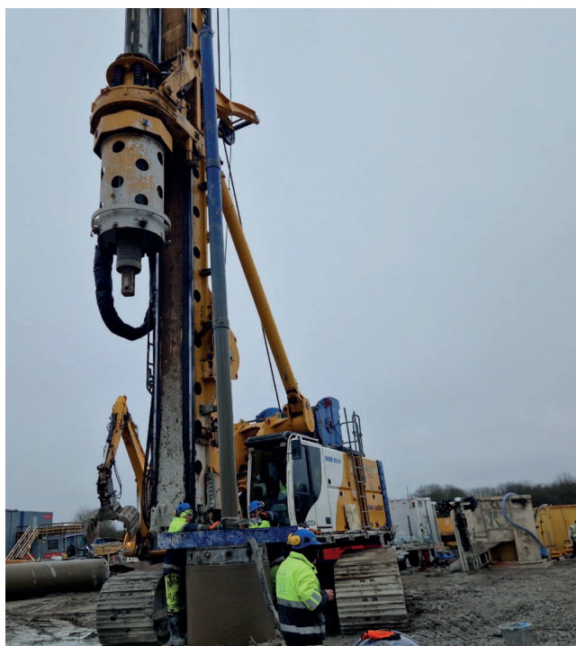
↑ Anlægsarbejde i forbindelse med anlæg af Valby Skybrudstunnel, foto HOFOR
