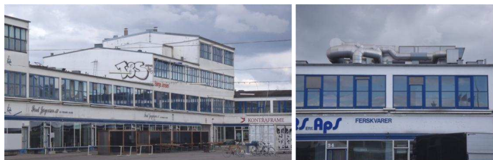
Figur 9-3 Eksempler på facader i Kødbyen. Billedet til højre viser en nyere teknisk installation på taget af randbebyggelsen, der vender mod Skelbækgade.
