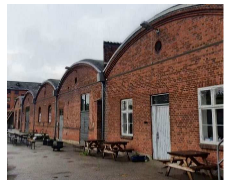
Facadetrækning af fem bevaringsværdige gavle på produktionshaller fra start 1900-tallet. SAVE-værdi 4.
