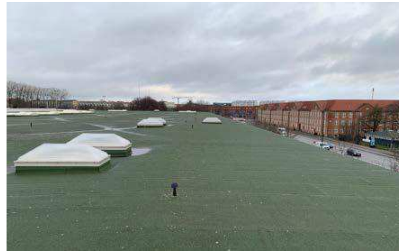
Figur 3: Billede af tagbelægning.
