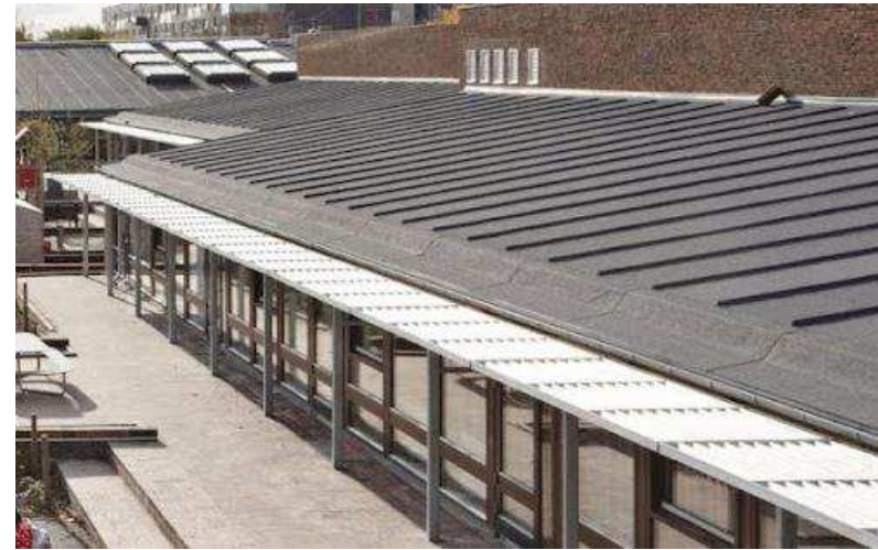
Figur 3: Billede af tagbelægning.
