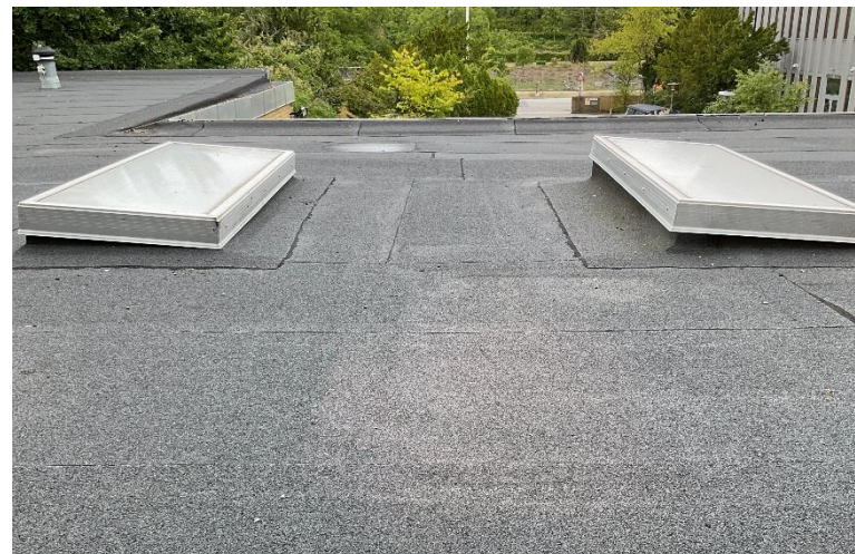
Figur 3: Billede af tagbelægning. Kilde: Tilstandsvurdering 2022
