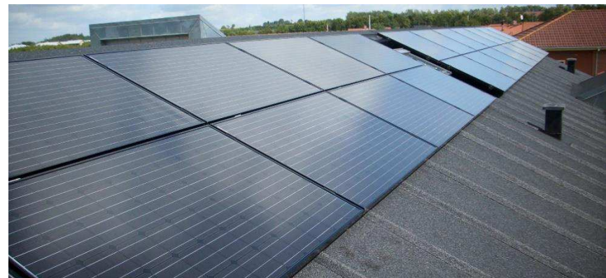
Figur 7: Billede; CIRKEL ENERGI WEBSHOP. Eksempel på solceller monteret på tag beklædt med tagpap. Samme oplægningsmetode forventes at kunne benyttes. Befæstelsen udføres i tagets spær med skærmskiver, bolte og tætningsmateriale.
