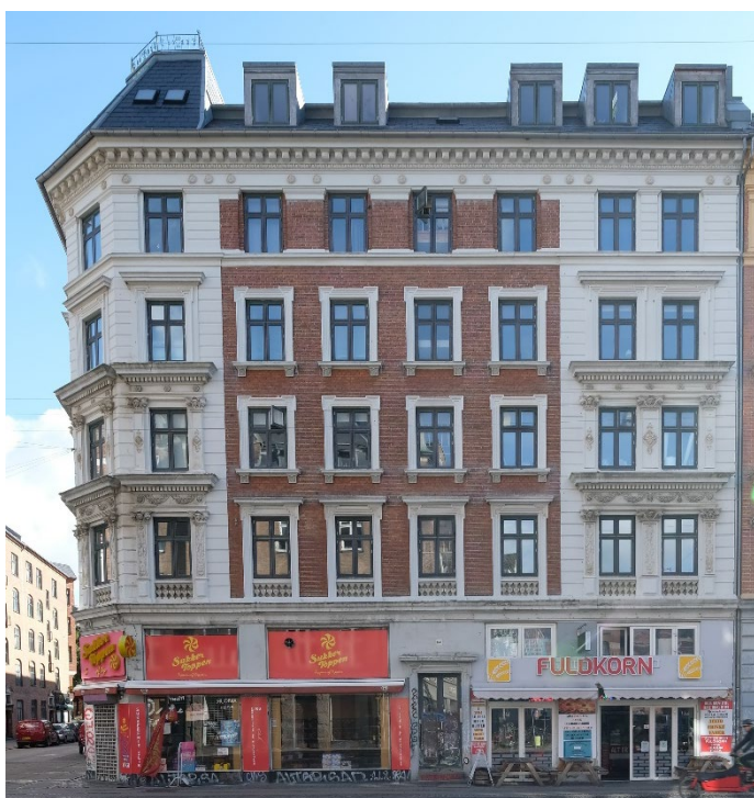
Eksempel på en bygning fra 1883 med en SAVE-værdi på 4, hvor der ikke kan etableres altaner på grund af de mange dekorationer på facaden.
