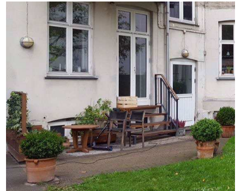
Trappe til terræn etableret vinkelret på facaden.
