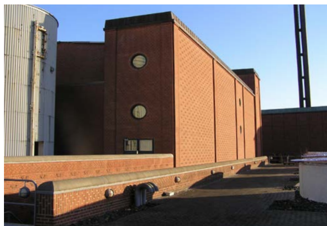
Gærkælderen, en af de bygninger, der kan nedrives i lokalplanen
