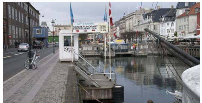
Billetsalg med anløbsbro, som ikke forskønner promenaden og det fredede bolværk.
