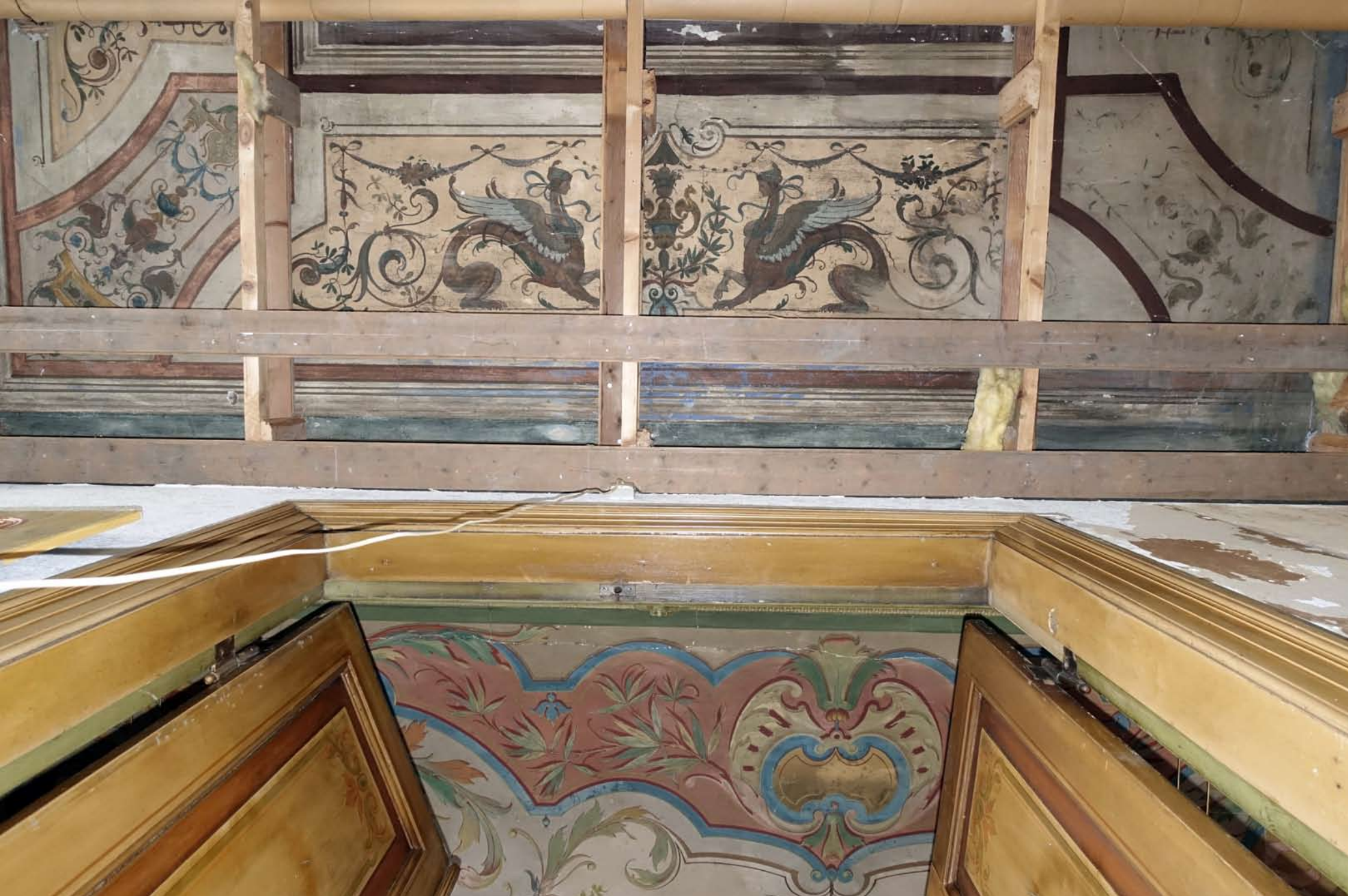
Inger Hansens Minde, Oliefabriksvej 2, 2770 Kastrup
