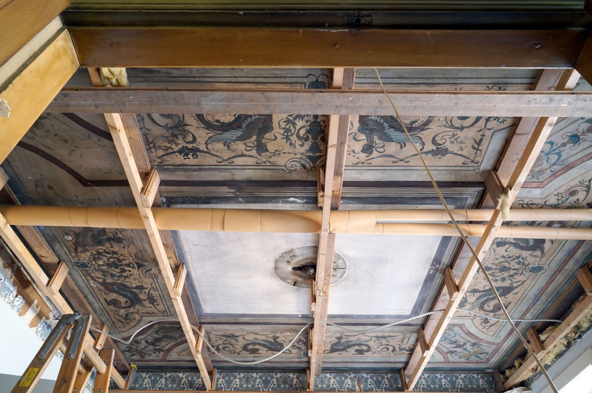
Inger Hansens Minde, Oliefabriksvej 2, 2770 Kastrup
