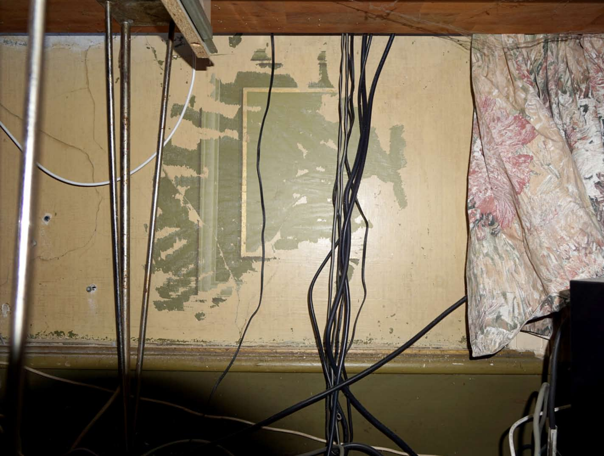
Inger Hansens Minde, Oliefabriksvej 2, 2770 Kastrup
