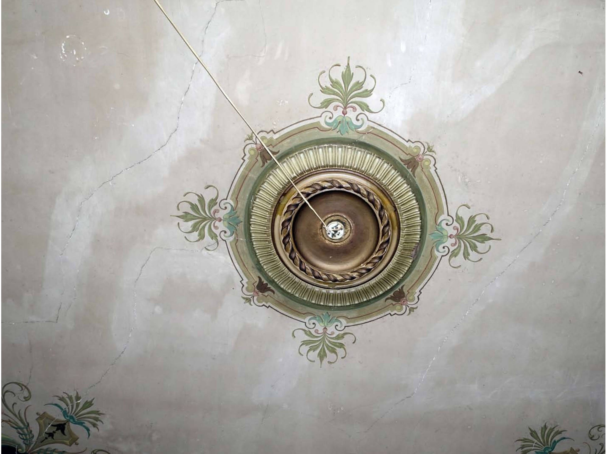
Inger Hansens Minde, Oliefabriksvej 2, 2770 Kastrup
