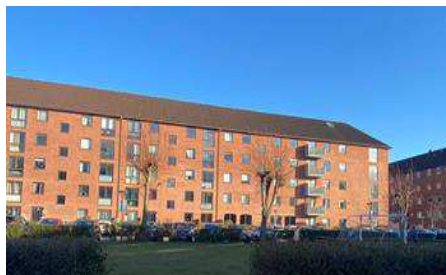
Boligblok med overvågning
