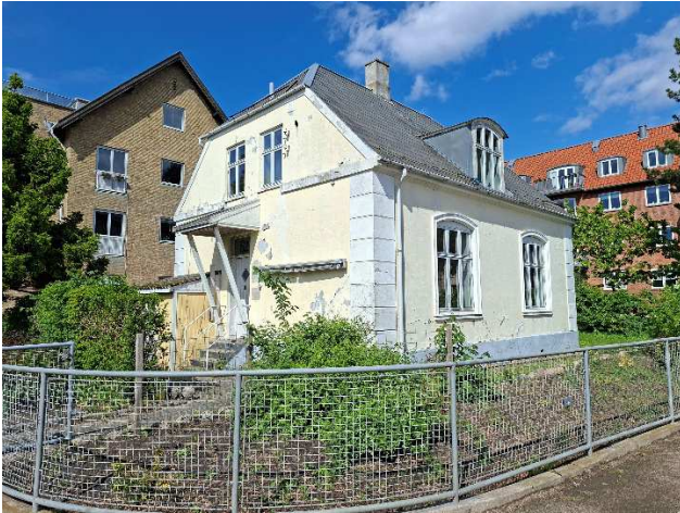
Facade mod henholdsvis gaden og gården (foto maj 2026)
