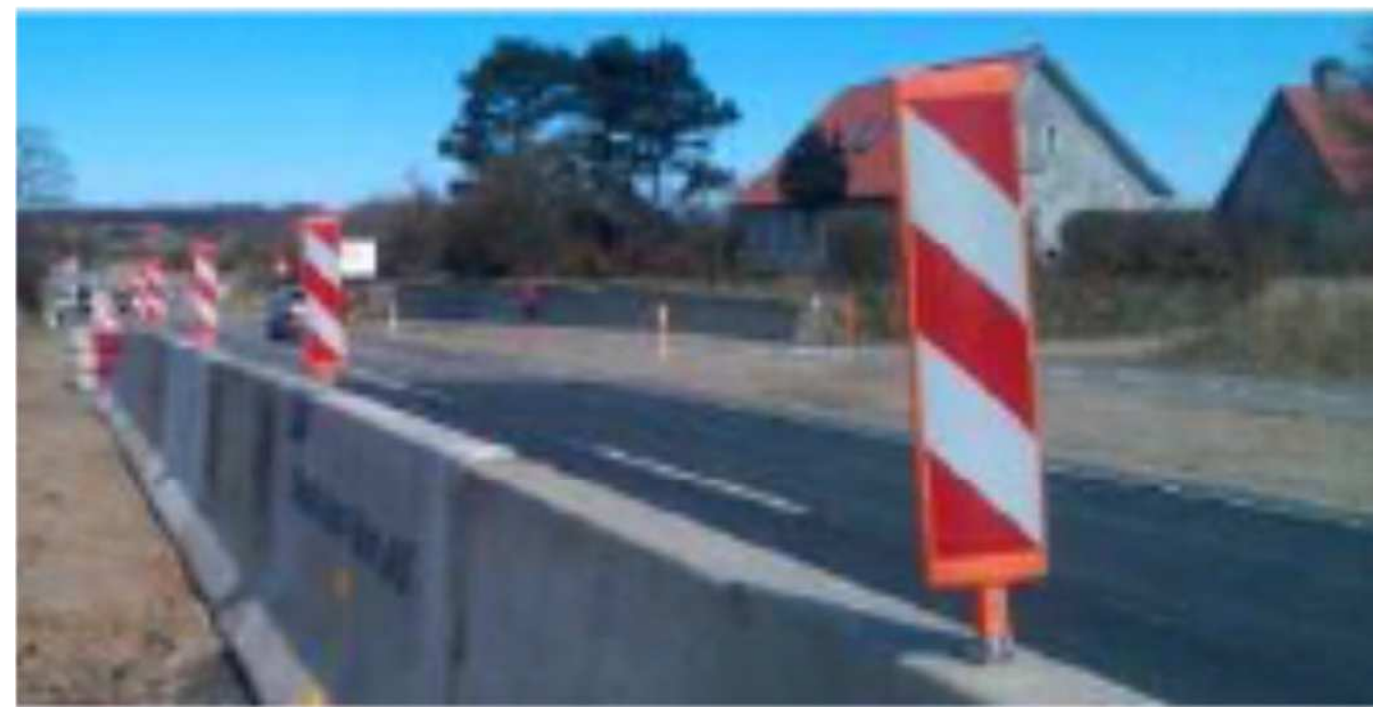
Eksempel på afspærring med trafikværn påmonteret N42 Kantafmærkningsplader i størrelsen 50x12,5 cm. Billedet er fra Vejregler, Håndbog om Afmærkning af vejarbejder, oktober 2013, figur 6.17, s. 108.
