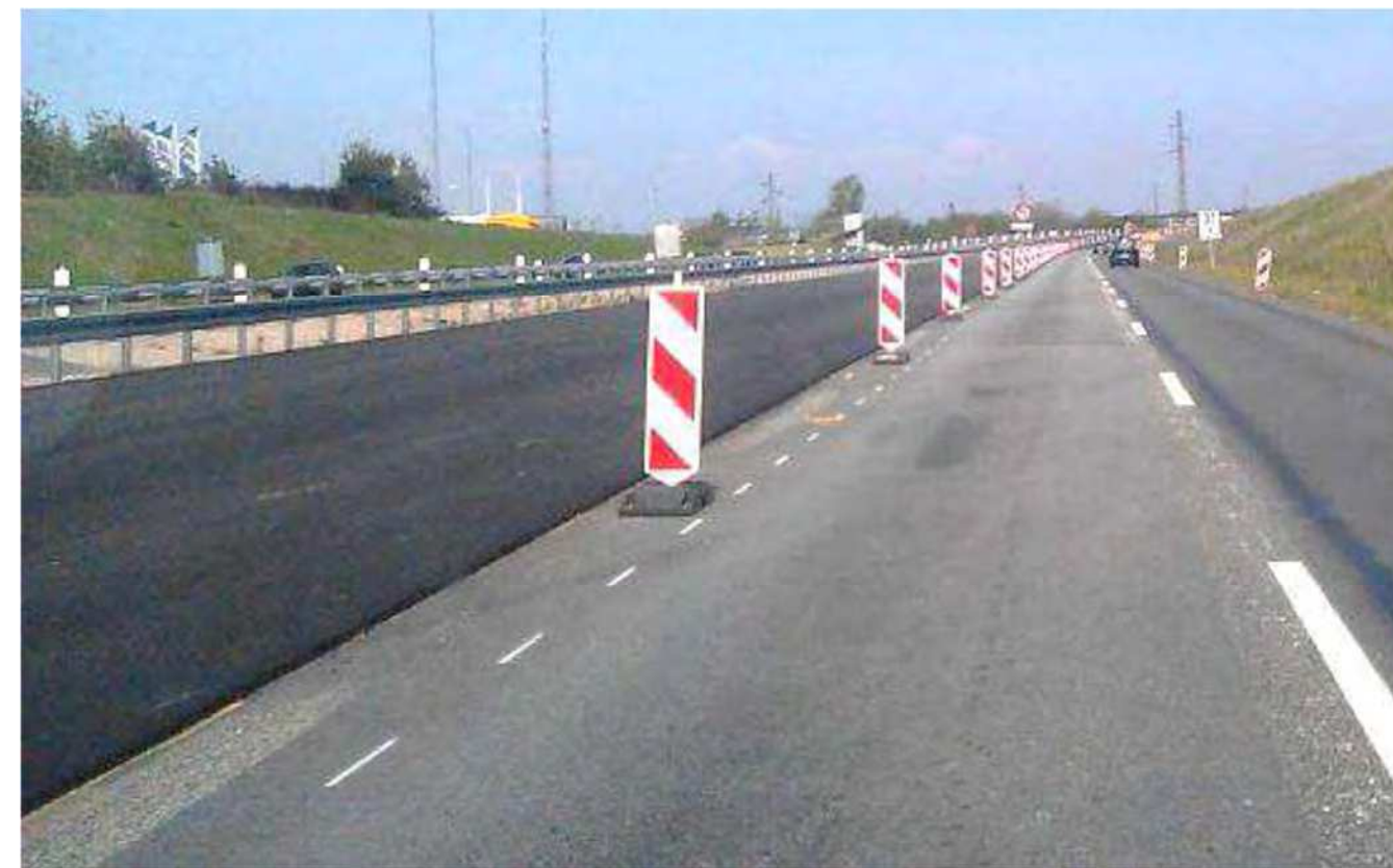
Eksempel på afspærring med N42 Kantafmærkningsplader i størrelsen 100x25 cm. Billedet er fra Vejregler, Håndbog om Afmærkning af vejarbejder, oktober 2013, figur 3.13, s. 50.
