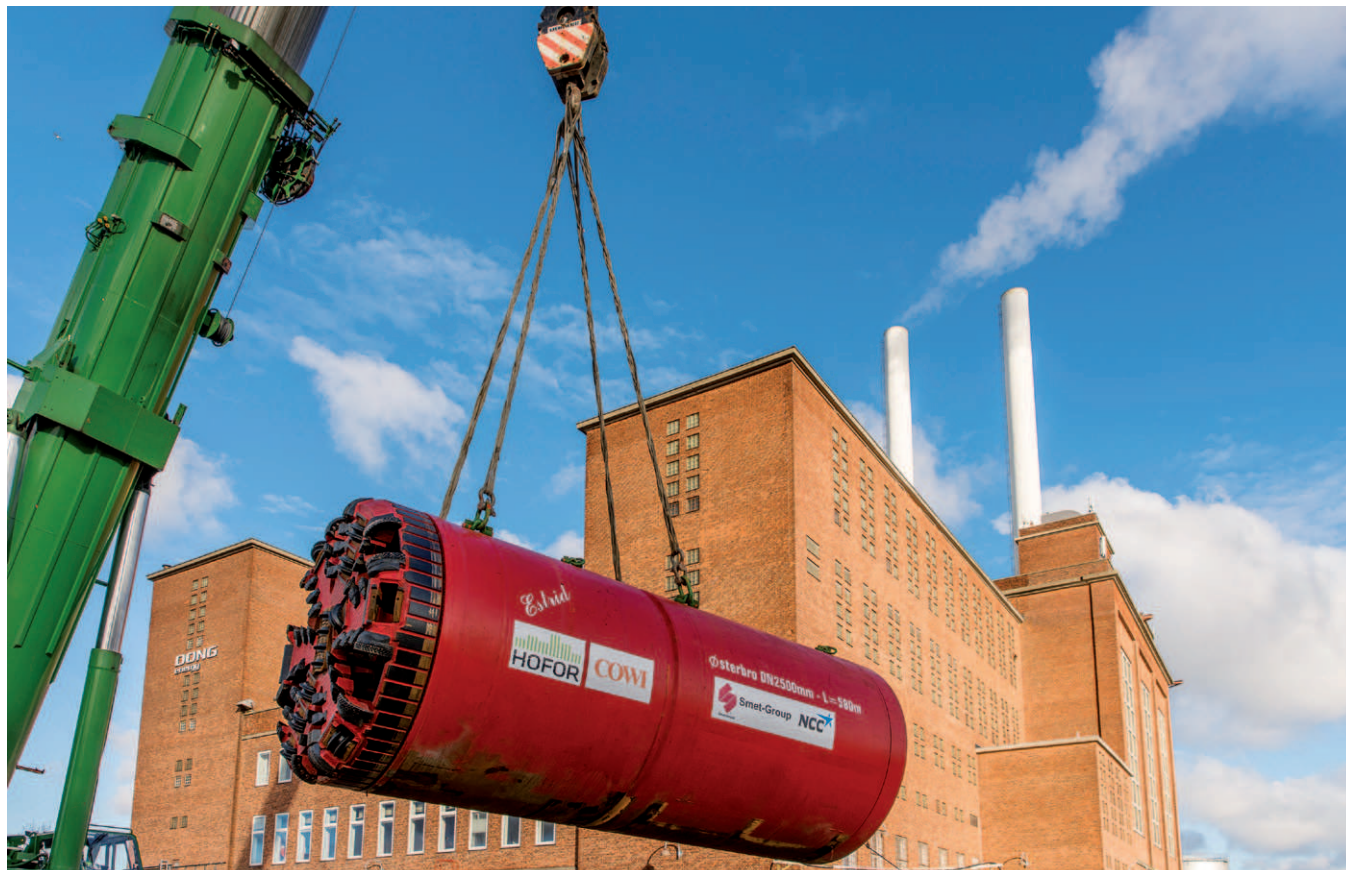
Tunnelboremaskinen Estrid bliver sænket ned og gjort klar til at bore regnvandstunnel på Østerbro.
