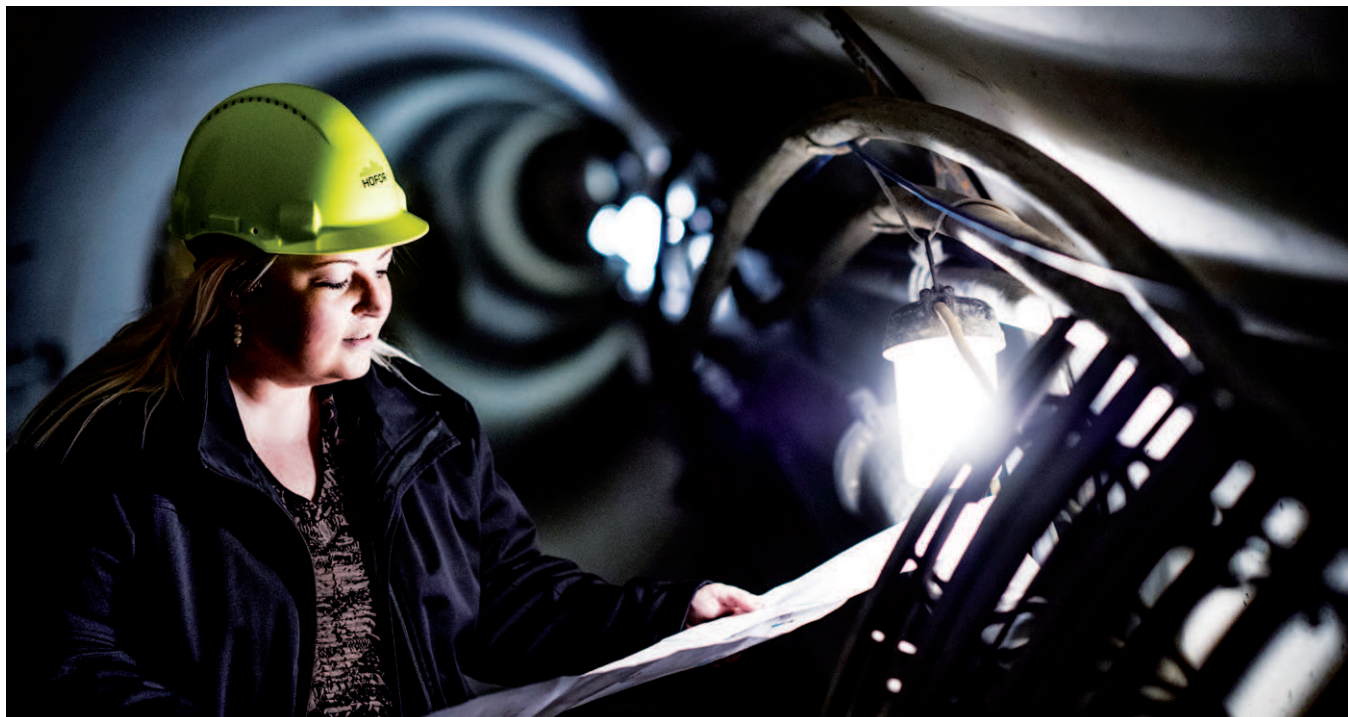
HOFOR kommer til at tunnelere mere i fremtiden – her er det udvidelsen af spildevandssystemet ved Damhusåen, men også rene regnvandstunneler skal anlægges flere steder.
