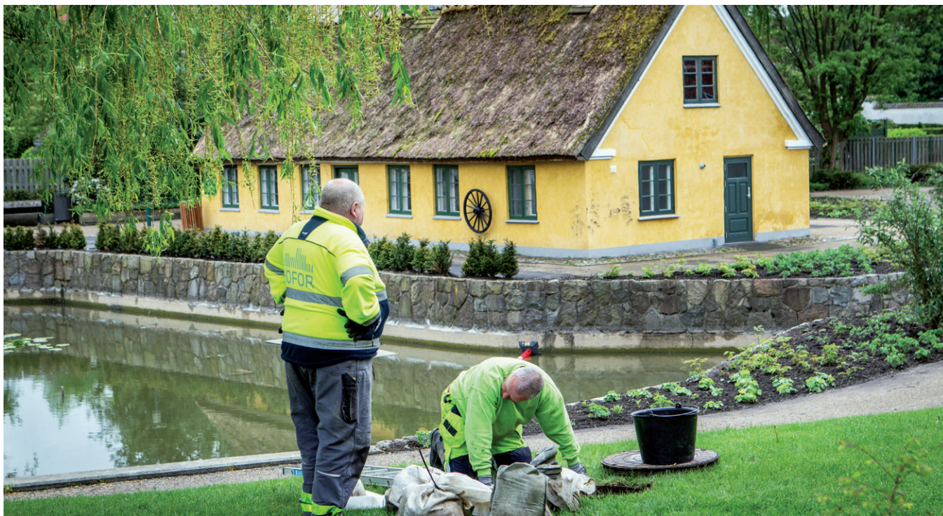
I 2015 er der i Herlev gennemført tv-inspektion af 2.675 meter spildevandsledning og 226 stik.
