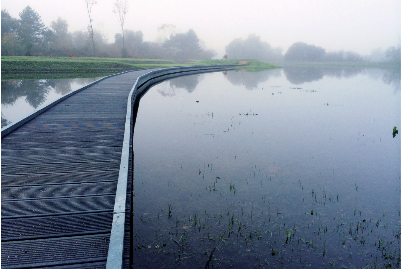
Skovmosen og Den våde eng blev indviet i 2015 og vil fremover mindske risiko for oversvømmelser på Vallensbæk Skole.
