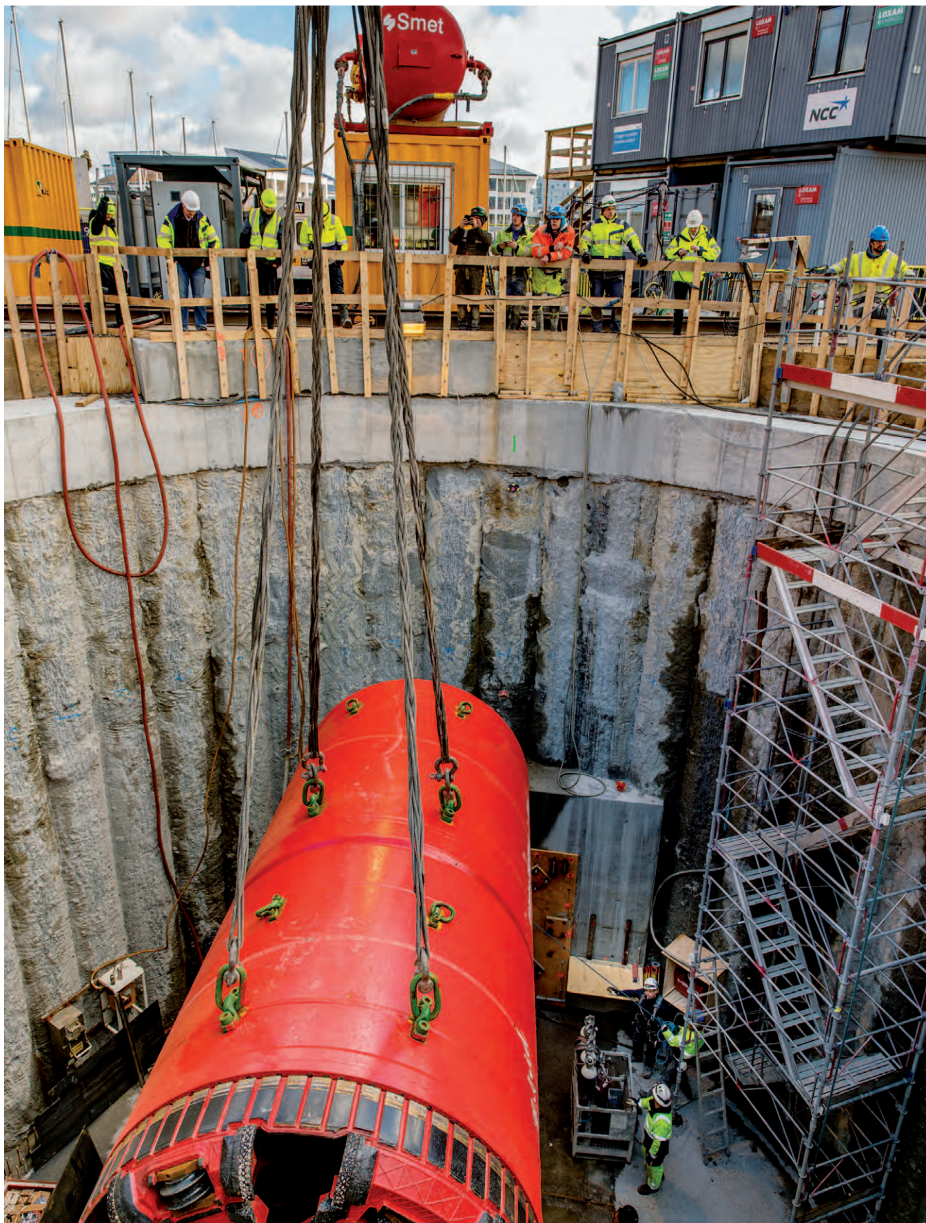
På Østerbro skal en regnvandstunnel være med til at sikre Ydre Østerbro mod oversvømmelser. Tunnelboremaskinen Estrid blev sænket ned i jorden i starten af 2016.
