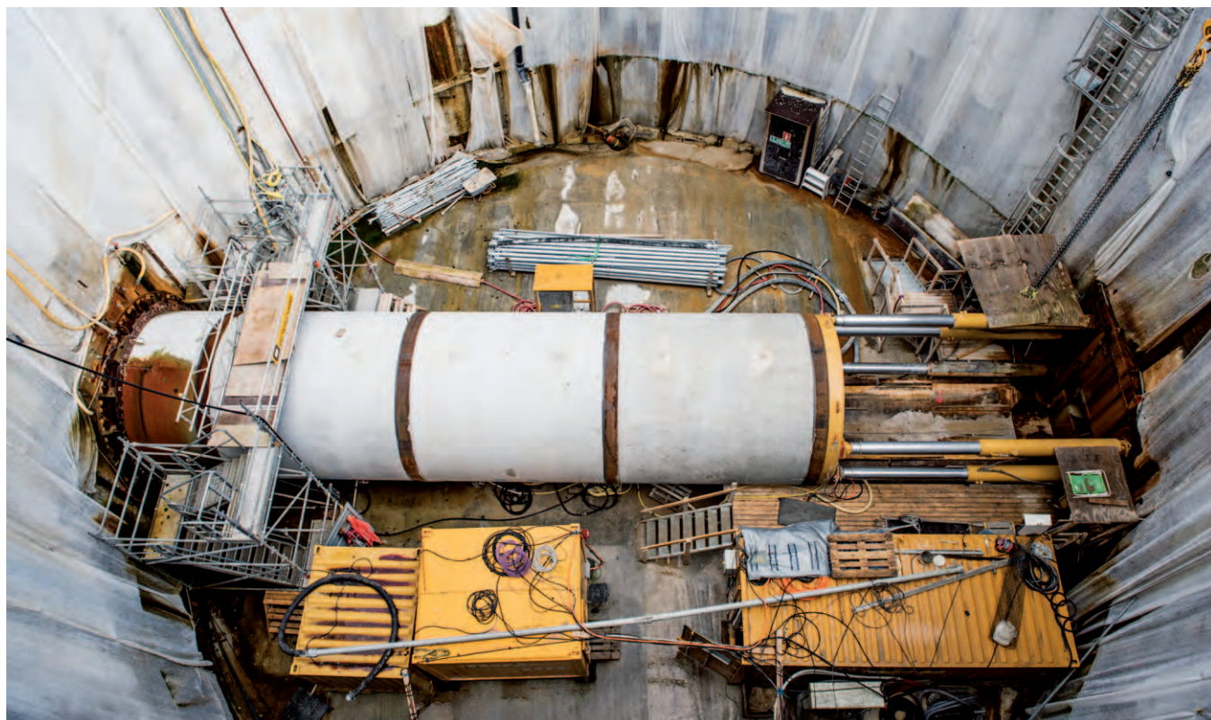
Ved Damhusåen skal to tunneler i fremtiden afhjælpe kloaksystemet og forhindre oversvømmelser. Her en af byggepladserne, hvor en tunnelboremaskine er sænket ned.
