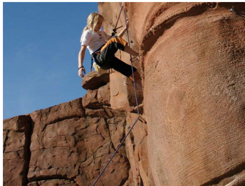
Eksempel på kunstig bjergvæg, opført i beton der er skulptureret til at ligne og føles som rigtig sten. Foto: Abekatten climbing walls
