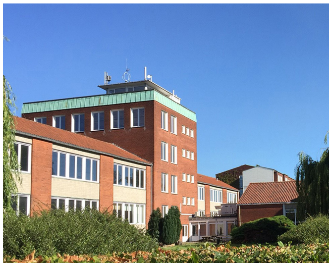
Den eksisterende bebyggelse set fra Jagtvej
