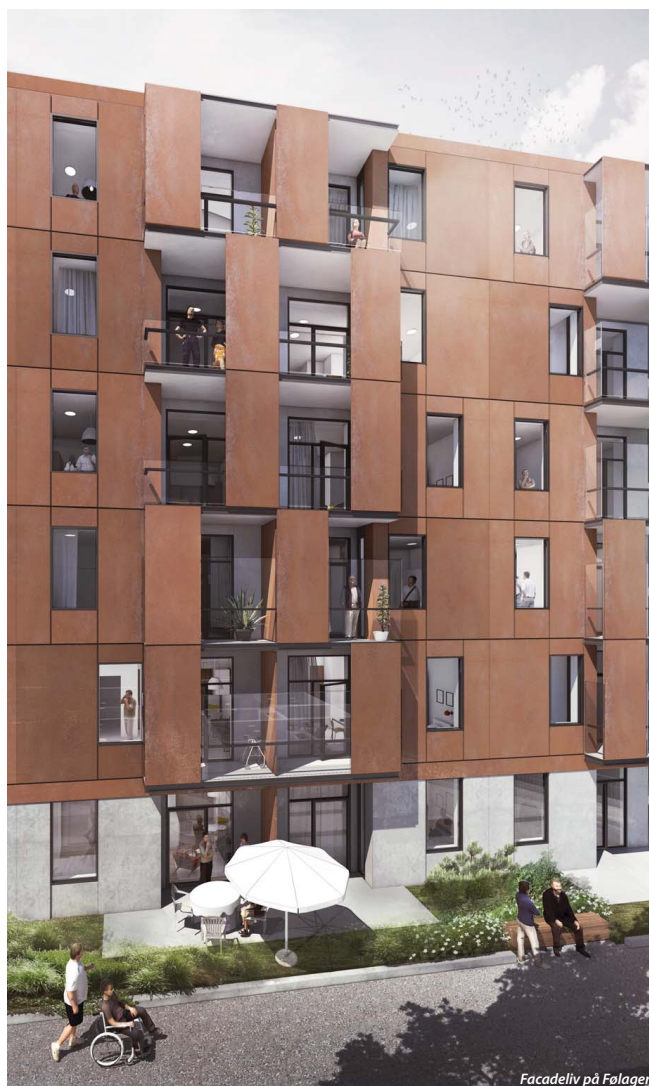
Facade - alle boligerne har store private bolig altaner der er delvist indeliggende og afskærmet for støj, de steder der er brug for det
