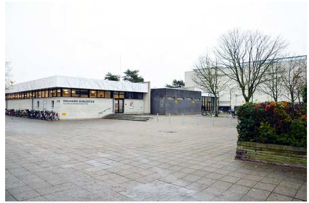
Biblioteket, som er beliggende i den vestlige ende af skolebygning og bibliotekspladsen, der omkranses af forholdsvis lukkede facader.
