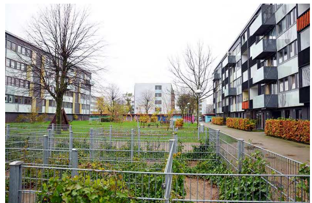
Remisevænget Øst til højre og tilhørende friarealer.
