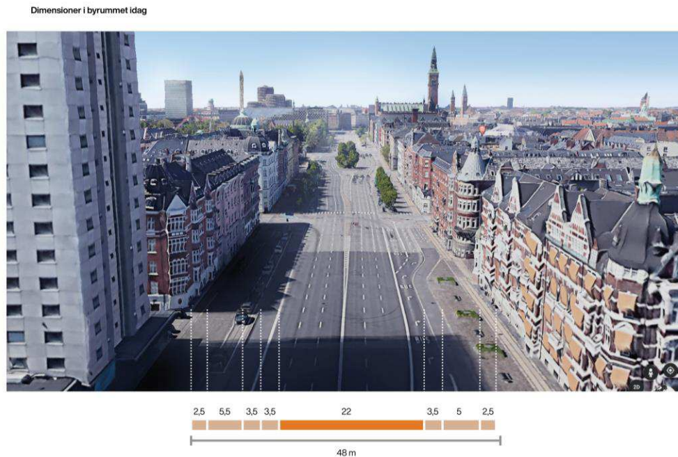
Figur 4-3 Nuværende forhold på H.C. Andersens Boulevard med angivelse af de enkelte tværsnitselementers bredde.
