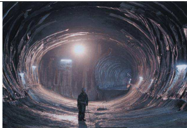
Figur 7-23 17 m bredt afgreningskammer i Københavns metro
