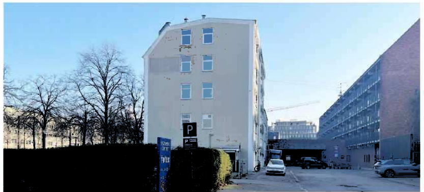
Eksisterende parkeringsplads omkranset af hæk, samt nedkørsel til parkeringskælderen ved Føtex set fra Ragnagade.
