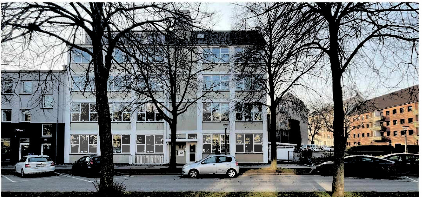
Eksisterende byggeri på Lyngbyvej 17, set fra Lyngbyvejen. Bygningen planlægges transformeret med ny 5. etage, samt en tagterrasse. Det nye byggeri muliggøres på parkeringspladsen til højre for den eksisterende bygning.
